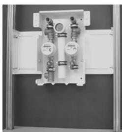
3. Messstation Sanitär-Abwasser auf dem Montageriegel so anhalten, dass die Abfluss-Rohrleitungsmitte 500...550mm über dem späterem Fertigfußboden beträgt. Befestigung auf dem Montageriegel mit selbstschneidenden Schrauben bzw. vorbohren und montieren.
